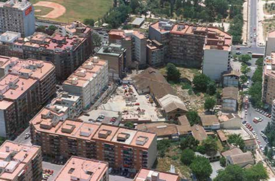
Vista aérea de los antiguos Talleres Devís Noguera, en el centro de la manzana, calle Arzobispo Fabián y Fuero, 1993. En la actualidad es un centro de formación de la Fundación Laboral de la Construcción.
