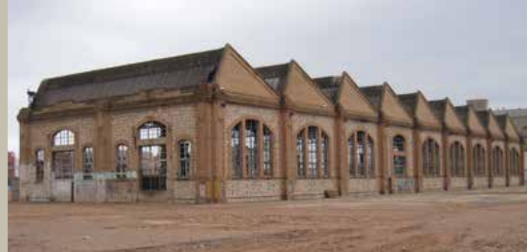
La Nave de Máquinas o Nave N° 13 salvada del derribo, 2009.
