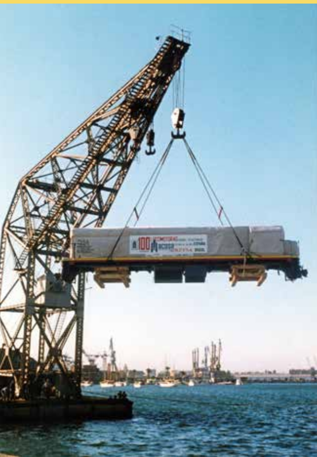
[Izquierda] Carga a barco, con la grúa flotante de la Junta de Obras del Puerto de 80 toneladas, de una locomotora 6200 RFFSA para Brasil, 1971.
